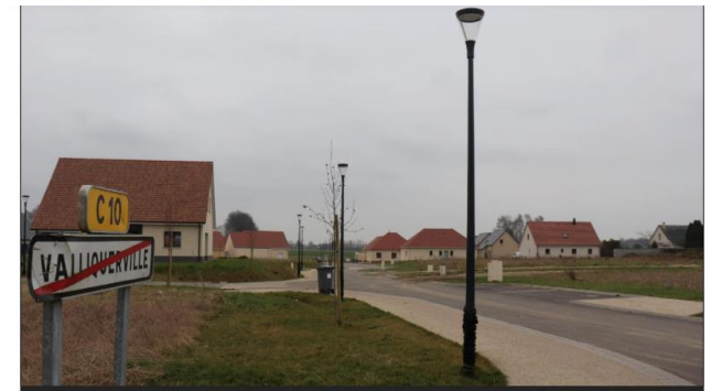
Construction de nouveaux lotissements à Valliquerville
